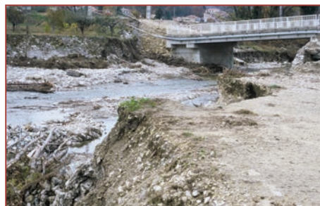
> Pont à Montjoux (source : SMBVL) |
