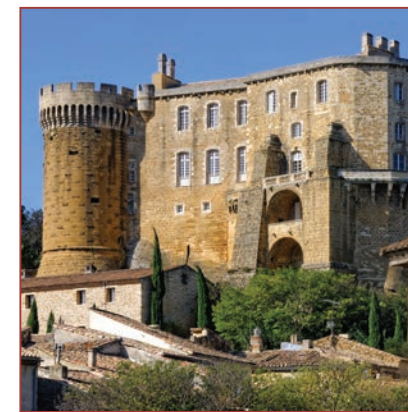
> Château de Suze-la-Rousse (source : Drôme Provençale) |
