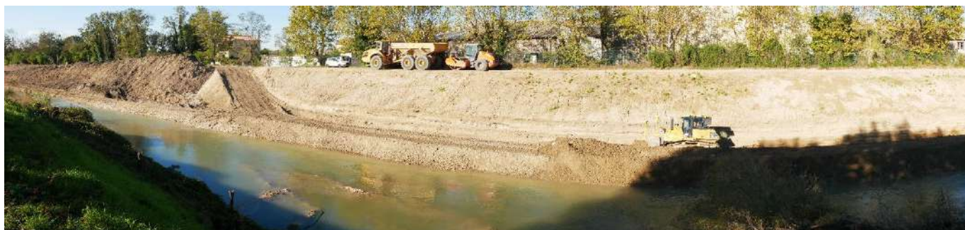
Reprofilage – Digue aval rive droite du pont de Chabrières – décembre 2023
