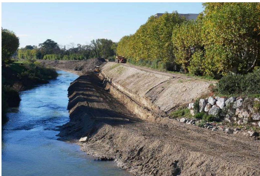
Décapage, reprofilage aval RD pont de Chabrières
