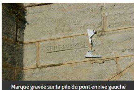
Marque gravée sur la pile du pont en rive gauche
