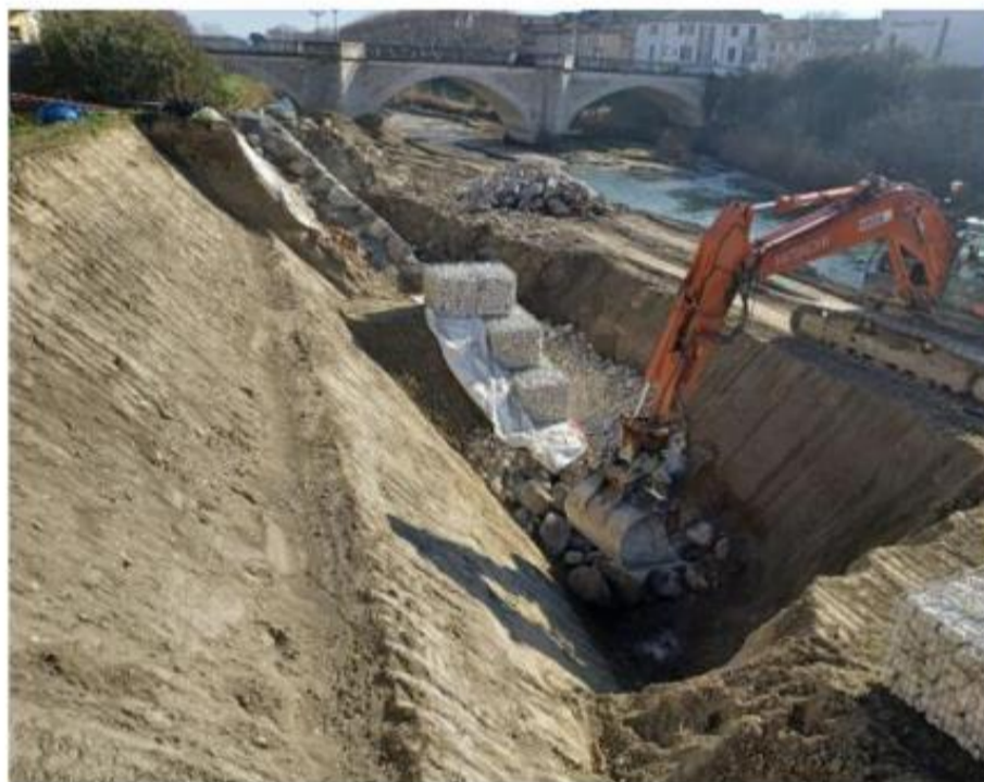
La pose des gabions a débuté depuis le lundi 29 janvier sur la rive droite, à l'aval du pont de Chabrières.
