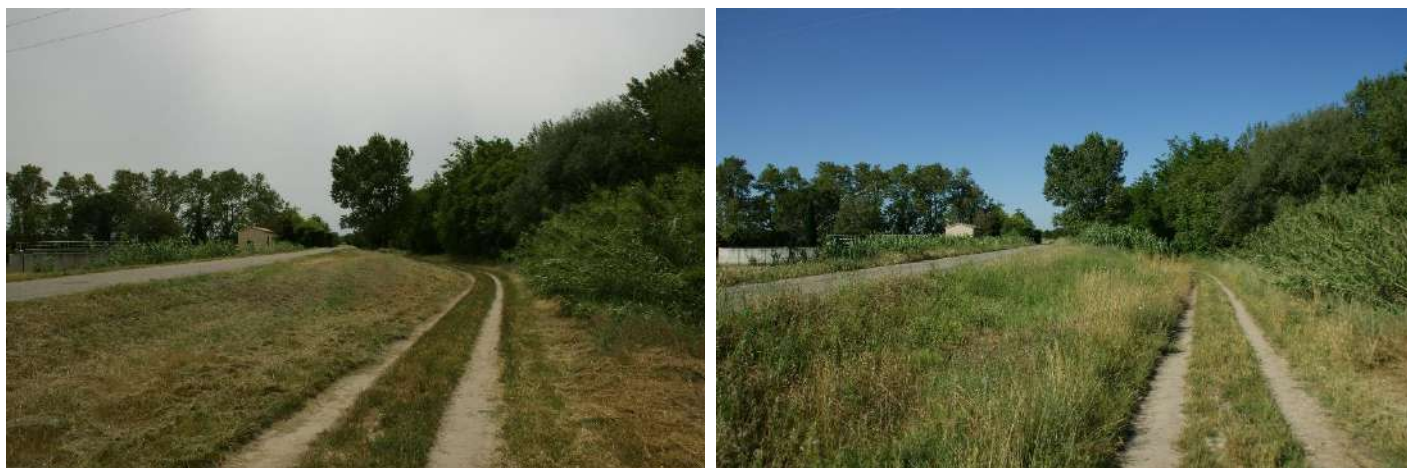
Photo avant/après : travaux d'entretien avant VTA – digues Bollène
