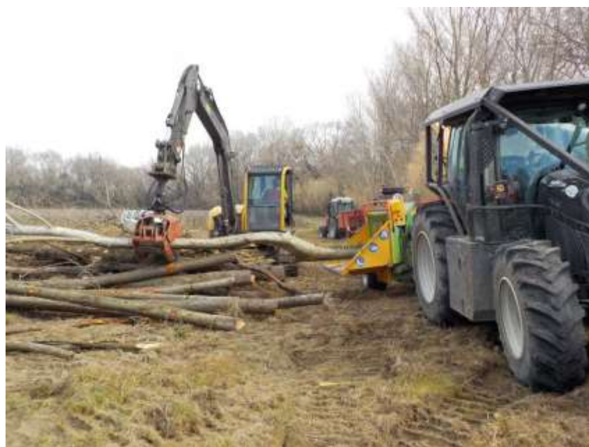
Broyage des arbres non conservés
