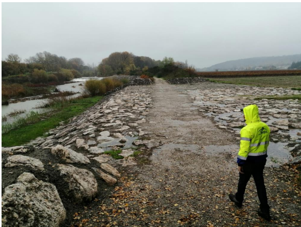
Poste de coordination SMBVL et surveillance terrain le 01/12/2019
